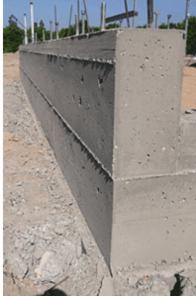
Pared de hormigón hecho con ceniza voladora.
